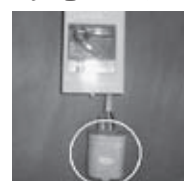
▲低圧進相コンデンサ (外觀は、メーカー によって異なります)
