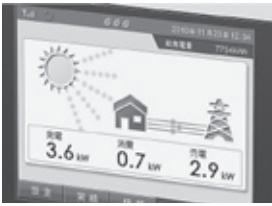
▲発電量のモニター
