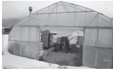
▲ペレットボイラーを設置
