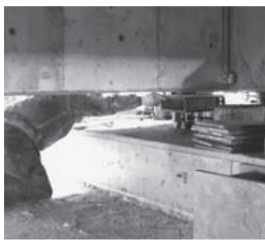
▲現本庁舎のジャッキアップ作業の様子
