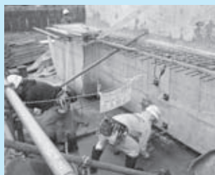
▲基礎の切り離し作業の様子
