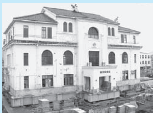
▲曳家に向けての作業が進む現本庁舎
