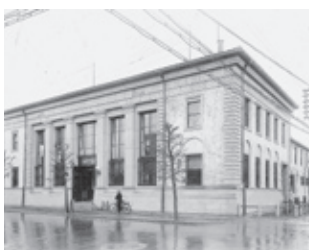
▲現市役所南庁舎別館が兵庫縣農工銀行豊岡支店だった当時の写真
