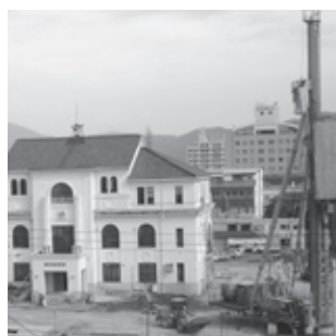
▲地盤改良工事では、約千本の砂杭を打ちました
