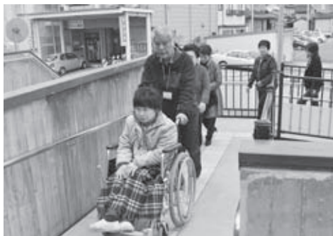
▲完成したスロープ通路
