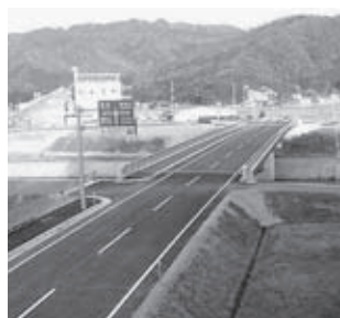
▲完成した鳥居橋
