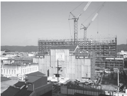
▲新庁舎の建設(建設中の新庁舎)
