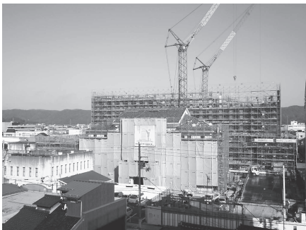
▲新庁舎の建設(建設中の新庁舎)
