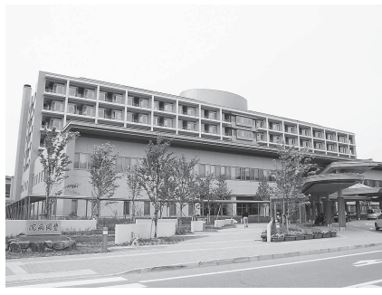
▲周産期医療センターの整備(公立豊岡病院)
