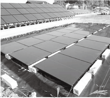
▲太陽光パネルの設置
