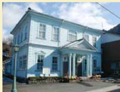
▲桜井が活躍していたころ(1887年)に建てられた旧出石郡役所「明治館」
