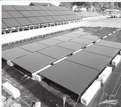
▲太陽光パネルの設置
