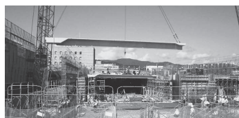
▲高層棟2階の躯体工事の様子
