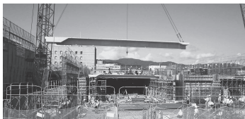
▲高層棟2階の躯体工事の様子
