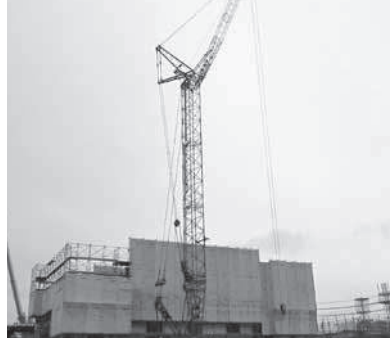
▲高さ約40メートルの大型クレーン
