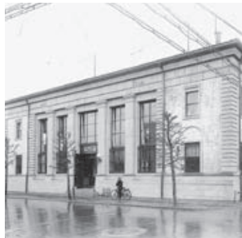
▲南庁舎別館(建設当時)
