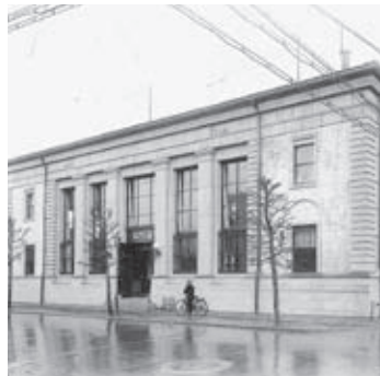
▲南庁舎別館(建設当時)
