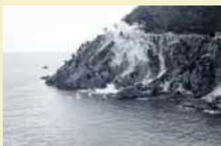
▲自衛隊による海岸道路岩壁発破工事
