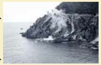
▲自衛隊による海岸道路岩壁発破工事
