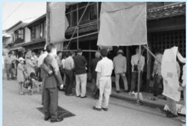
▲説明を聞きながら、修理現場を見学する参加者
