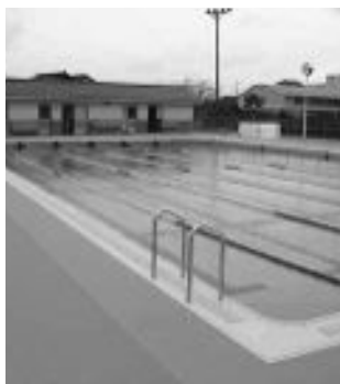
▲完成した竹野小学校のプール
