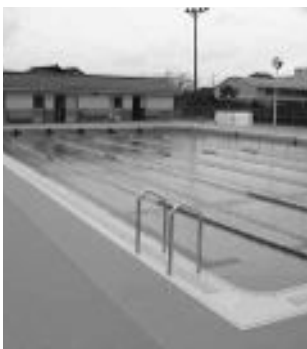
▲完成した竹野小学校のプール
