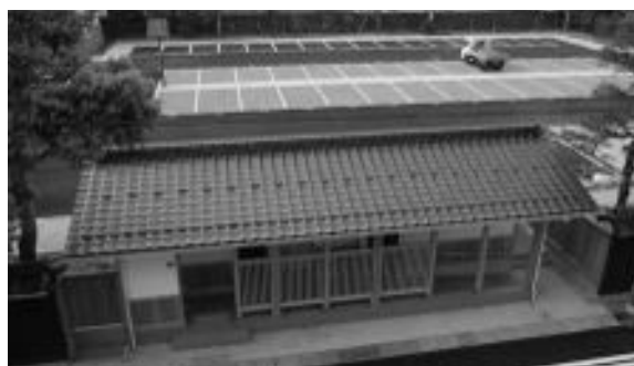
▲豊岡防災公園（手前建物：便所棟）
