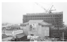
▲躯体工事が進み新庁舎の全容が明らかに
