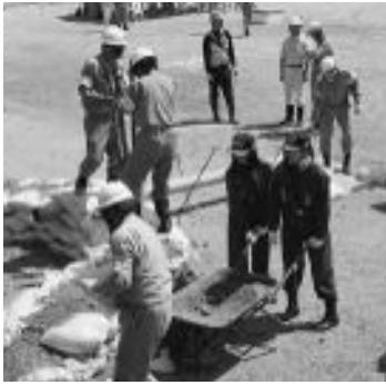
▲積み土のう工訓練の様子
