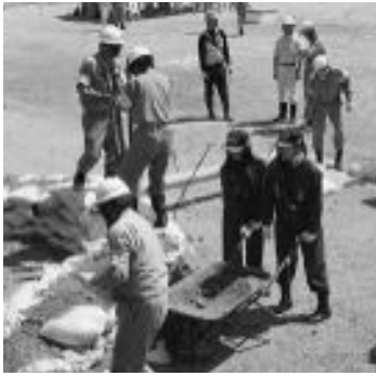
▲積み土のう工訓練の様子
