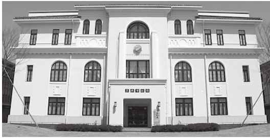
▲市立交流センター「豊岡稽古堂」(1・3階)
