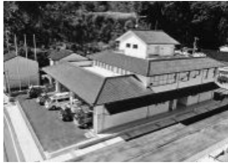
▲新しくなった豊岡消防署城崎分署
