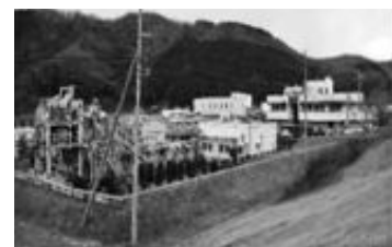
豊岡市浄化センター
