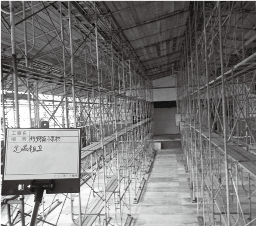
屋内運動場の吊り天井等落下防止対策工事
