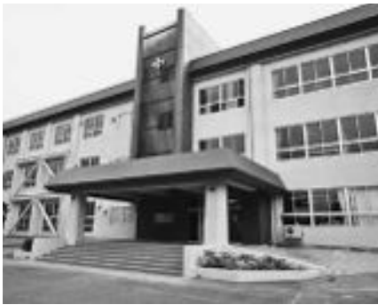
▲昨年度耐震工事が完了した豊岡南中学校
