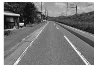
▲送水管布設完了
