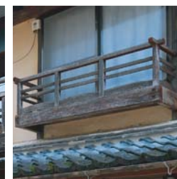
開口部 木製手摺 もくせいてすり
