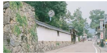
参考-家老屋敷の石垣と塀 城内であった内町や、城下の寺院、間口の広い町家では、塀や石垣をよく見かけます。
