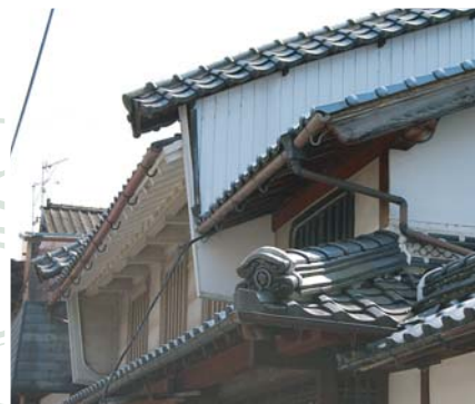
卯建 小屋根を持った重厚な卯建
