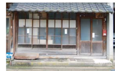
参考-建具による1階外壁 江戸から明治中期頃まで、ミセノマと外部の間仕切りは摺り上げ戸による形式で、日中は大戸を含めて間口全面が開放されていました。その後改変されますが、建具を用いた外観構成は変わりません。
