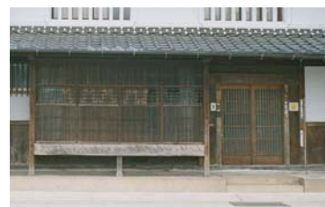
参考-1階外壁の特徴 初めから仕舞屋（しもたや）として建築された町家や、間口の広い町家では通りに面する部分に壁を持つものもあります。壁は左官仕上げによる真壁を基調とし、板張の腰を備えます。
