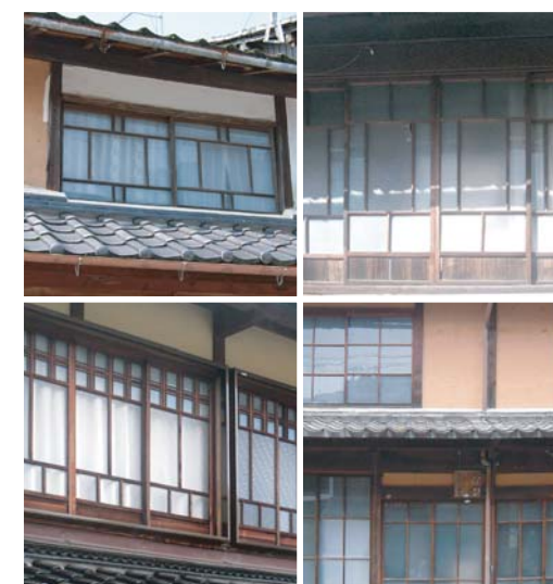
木製ガラス窓の例 左上・右上・左下： 意匠性の高いガラス割 右下： シンプルな格子の木製窓
