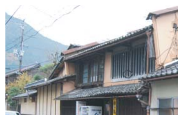
参考-大壁の2階外壁 間口の広い規模の大きな町家に限りますが、2階外壁を左官で塗込めたものも見られ、町並みに重厚なイメージを与えます。
