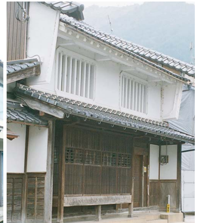
町家のパターン 左：簡素で軽快な真壁造り 右：重厚な大壁造り
