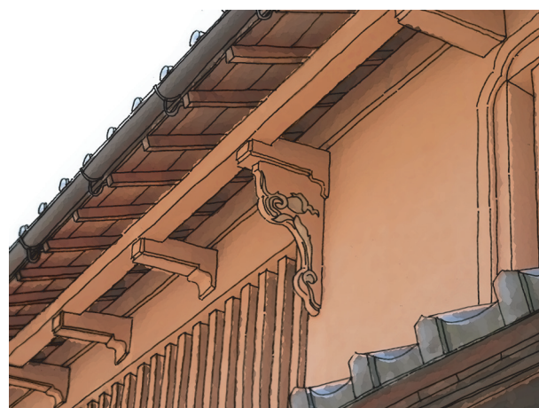
持送板 漆喰で塗り込められたタイプ
