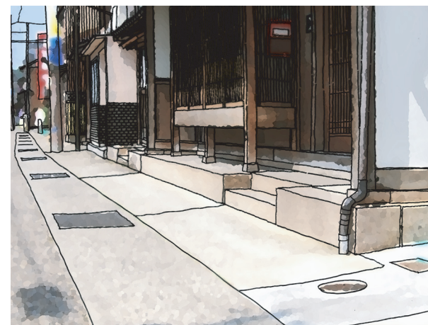
切石積・格子 切石積を持つ家屋が連続する
