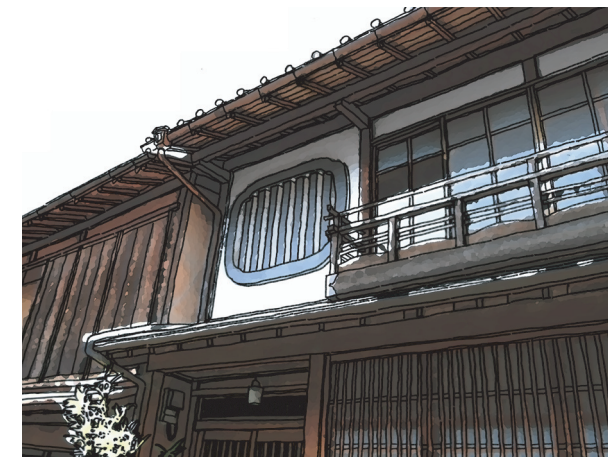
木製建具・木製手摺・虫籠窓 2階ザシキに木製手摺を備えた町家
