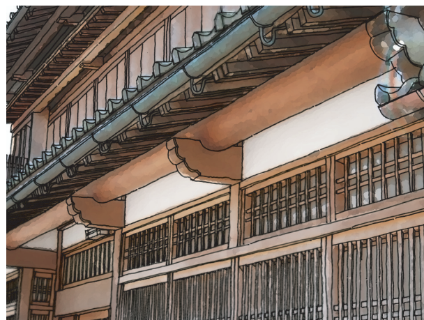
腕木 磨丸太の出桁を支える腕木
