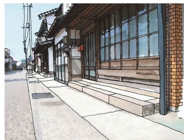
切石積 切石積の高さは場所により異なる
