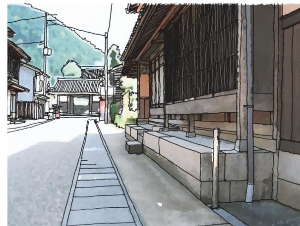
切石積・格子 切石積により家屋は大きく持ち上げられる
