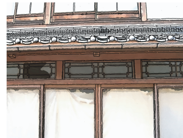
木製建具 繊細な意匠の木製欄間
