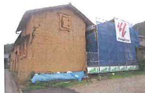
懸案の崩落も修理着工！
