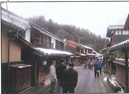
電柱、電線のない景観は、歴史的まちなみをさらに魅力的に！
