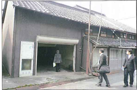
亜鉛鉄板やシャッター、アルミサッシの外観ですが・・・
