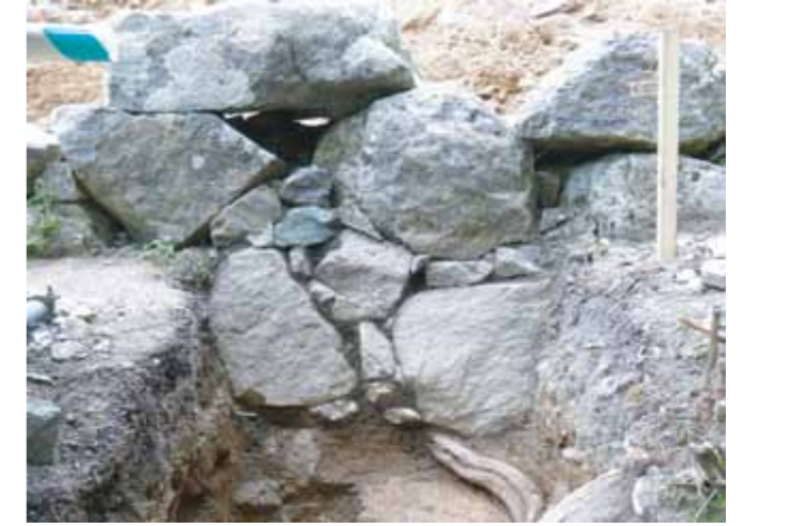
⑥ 石垣根石の状況 (ぎっしり詰められた間詰め石は築城当時のもの)
