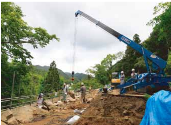
④ 石垣の解体
