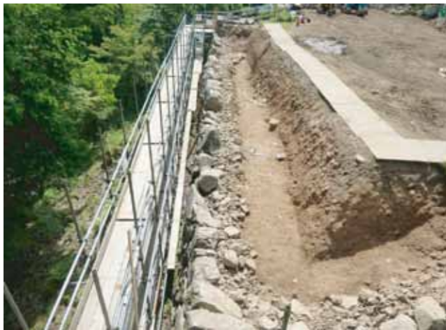
⑤ 清掃後、記録写真の撮影 (裏込め、盛土の状態を記録します)
