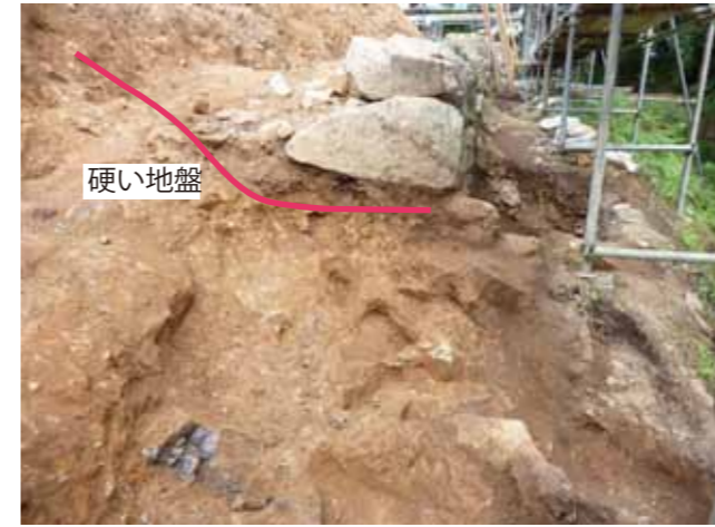
⑤ 地形根切りの痕跡 (硬い地盤を削りその上に石垣を造る)
