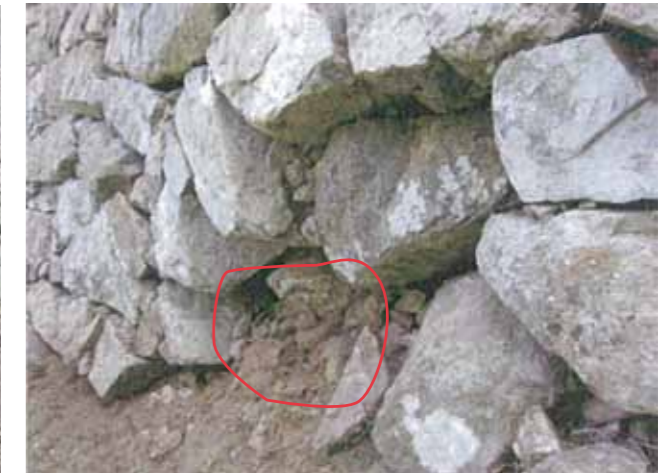
石垣石材(築石)の抜け落ち
