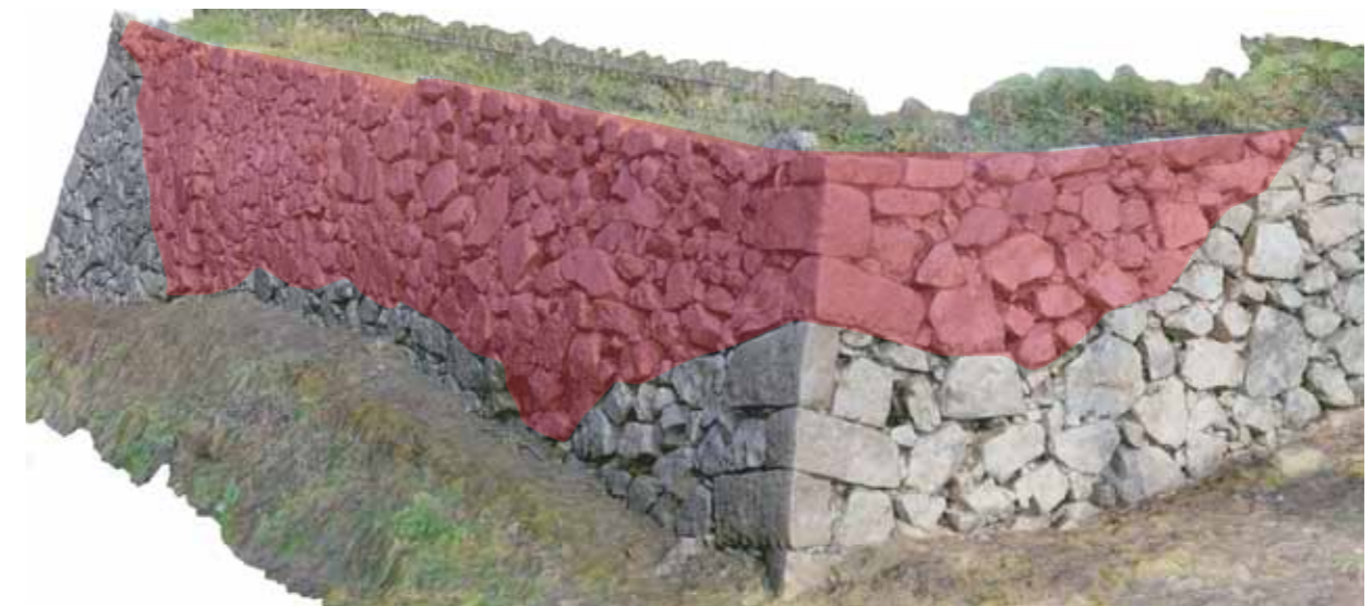
石垣解体範囲(赤く塗った部分)
