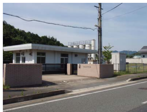
畑山浄水場（中央簡易水道）
