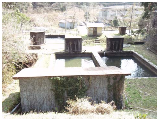
老朽化した施設（上水道事業：荒船浄水場）
