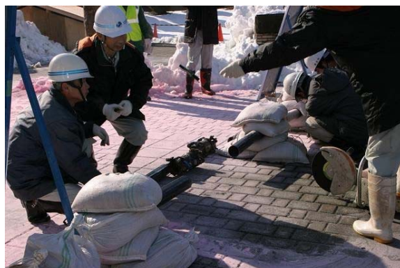
管路の復旧訓練
