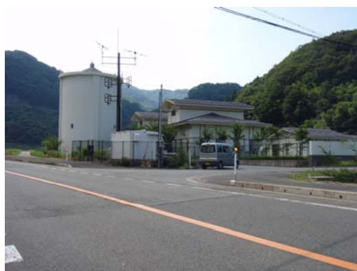
稲葉浄水場（神鍋地区簡易水道）
