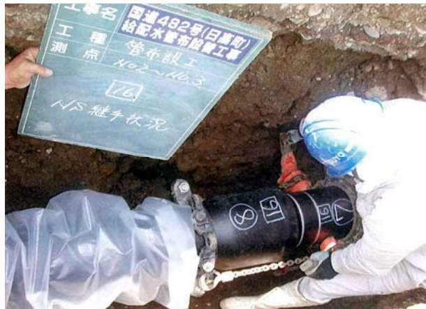
管路の耐震化工事
