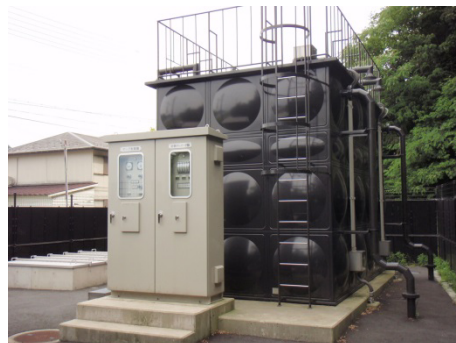
小島ポンプ場
