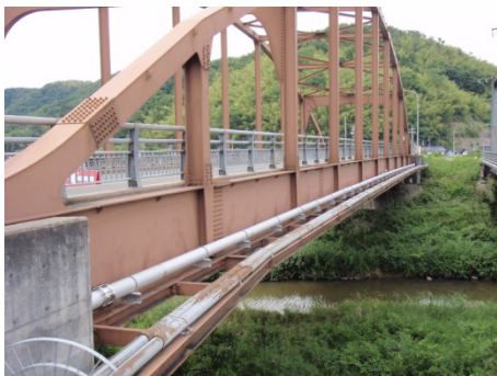
森津橋水管橋
