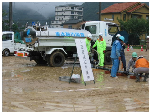
水道管復旧訓練（H27 豊岡市総合防災訓練）
