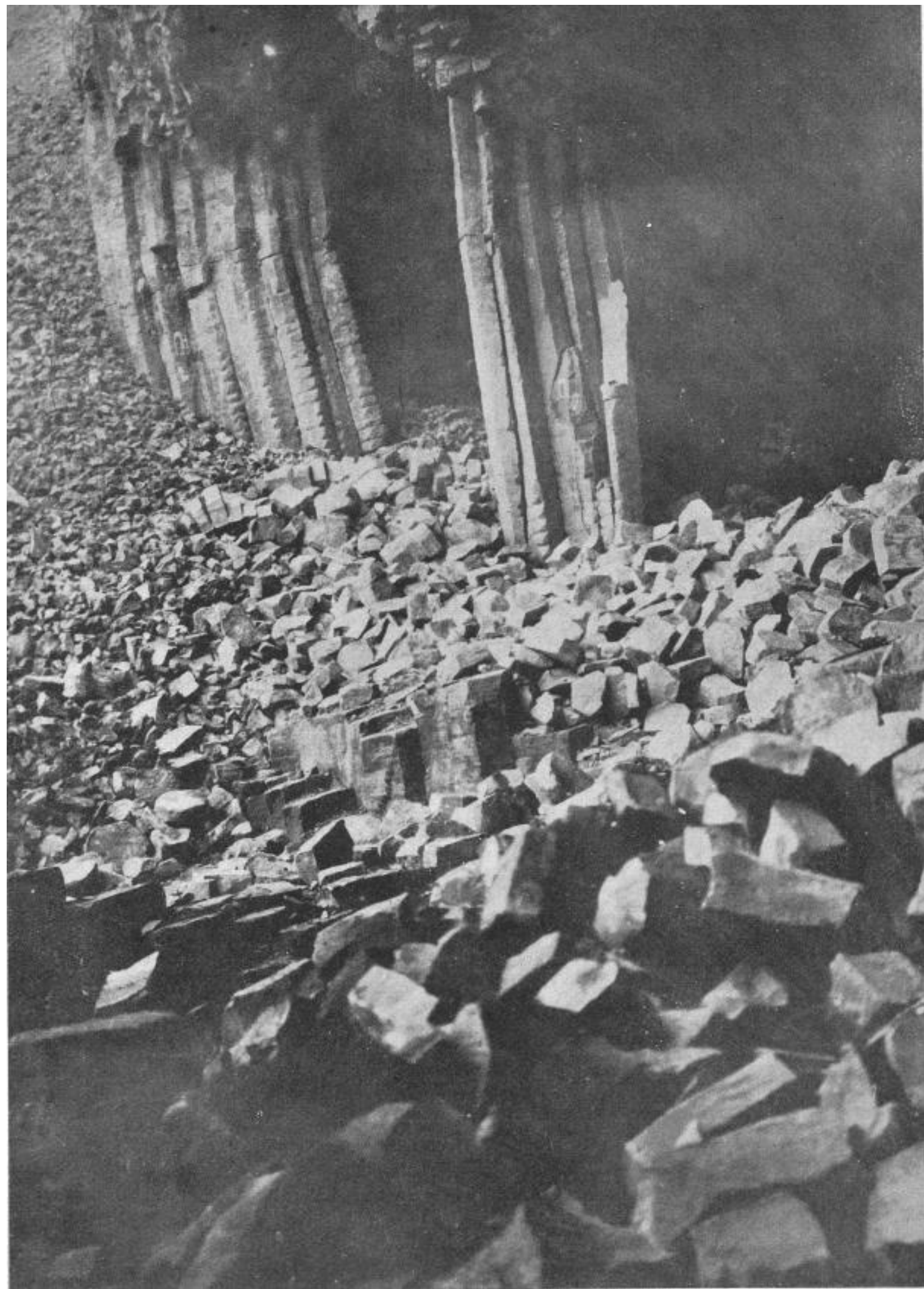
玄武洞の震害
