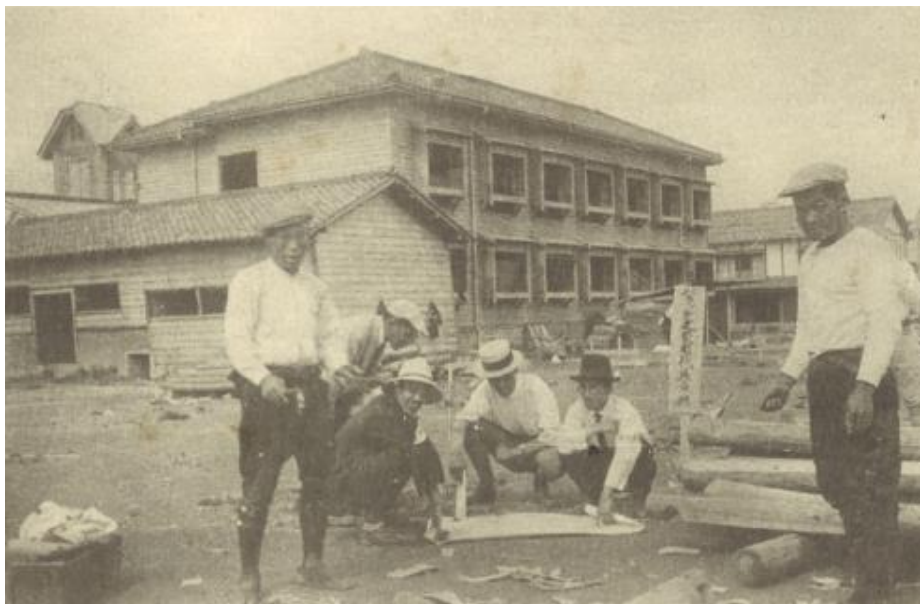
県営バラックの建設
