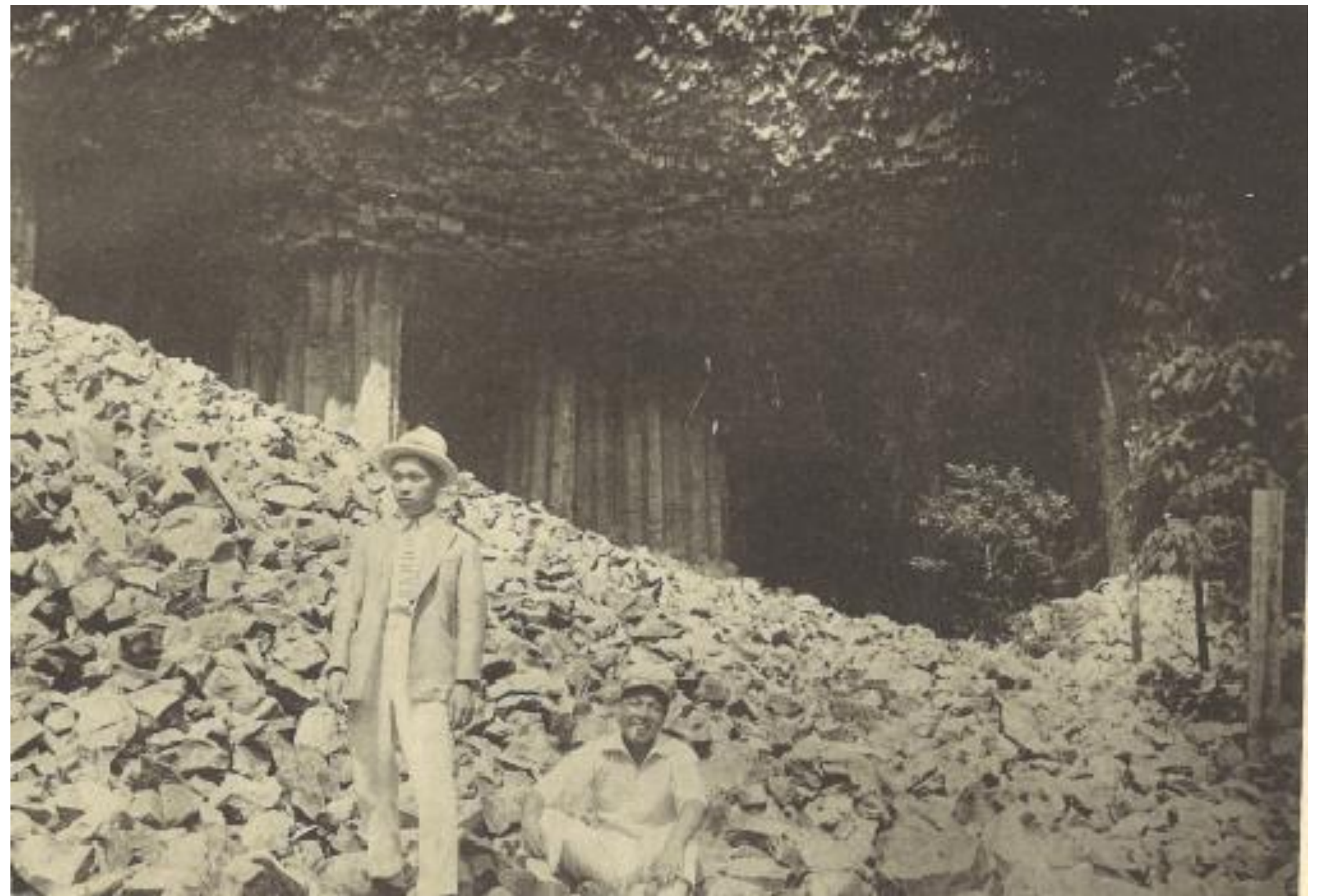
被害を蒙る玄武洞
