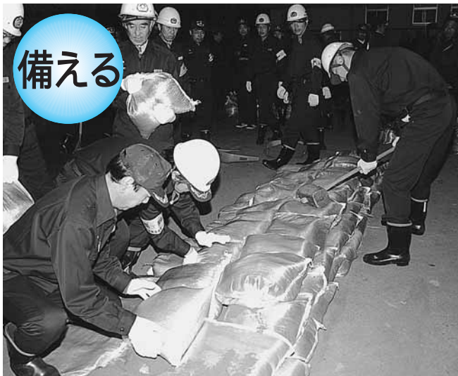
河川の越水を想定して、土のうを積み上げる消防団員
