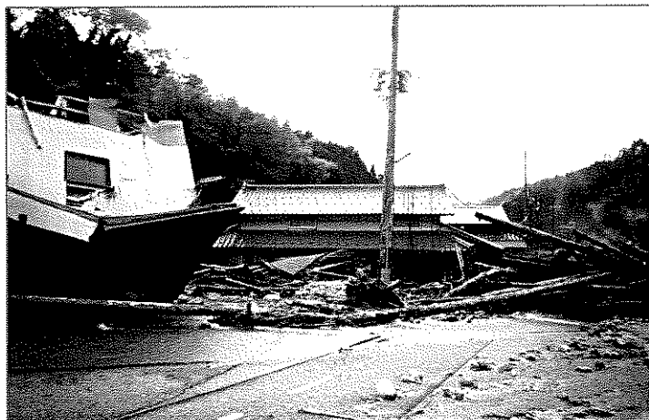
▲但東町奥赤 土石流で破壊された建物
