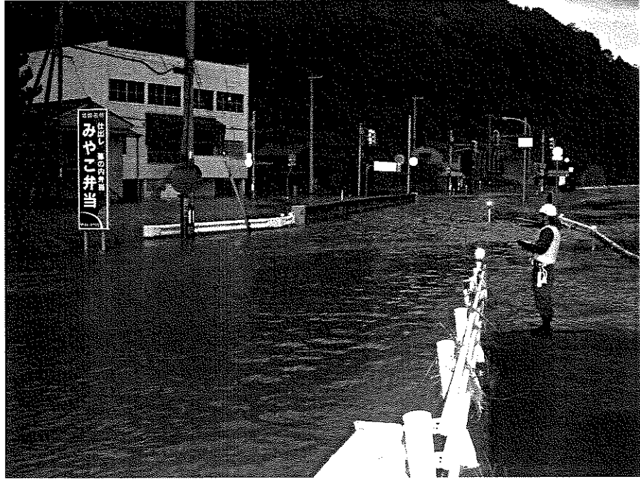
▲結和橋西詰め付近の冠水状況
